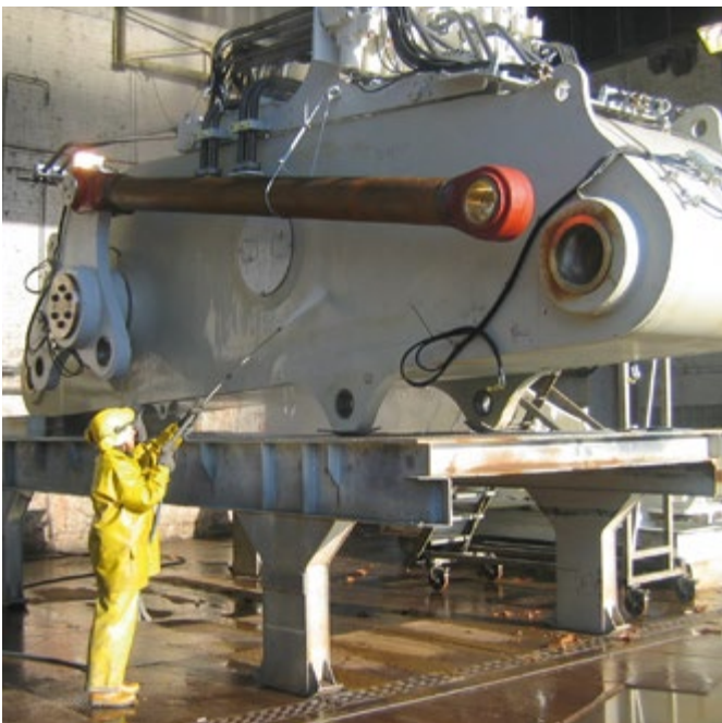
Ontlakken van installaties voorbereiden
