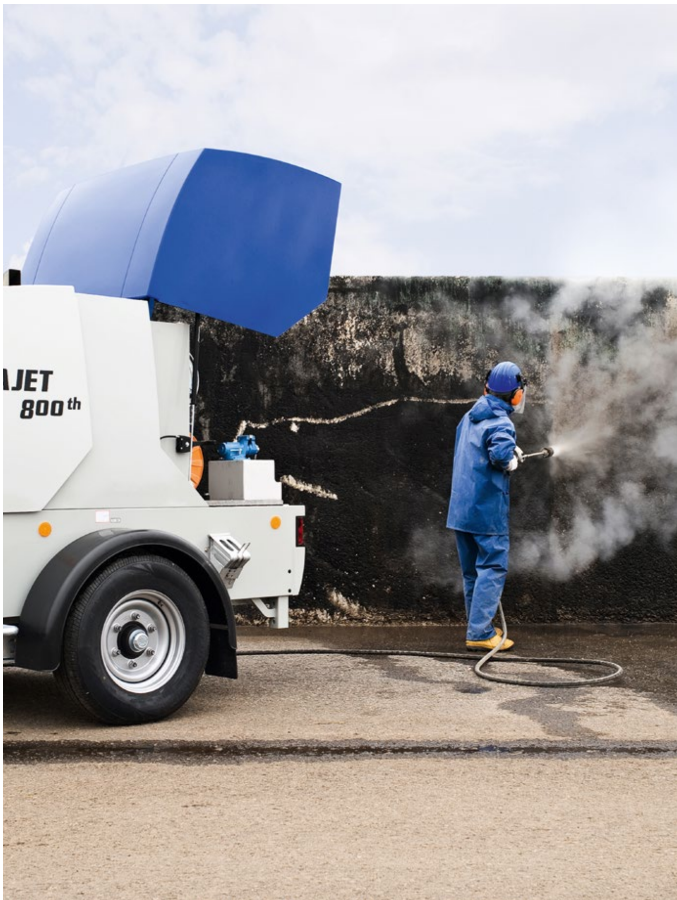
Renovatie van een keerwand
